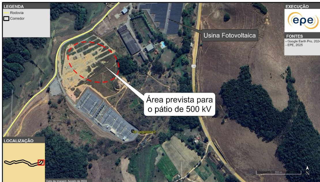
Figura 3 – Ampliação da SE Leopoldina 2
